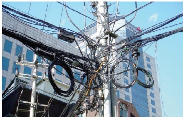
중점 정비 대상은 전봇대에 심하게 얽혀 있거나 뭉쳐있는 전력선과 통신선, 전봇대에서 여러 방향으로 복잡하게 설치되어 있는 공중케이블, 한 전주에 과다하게 설치된 통신설비, 전주에서 건물과 주택으로 설치된 복잡한 통신선, 과다하게 남겨진 여유선이다. **광주의향**
